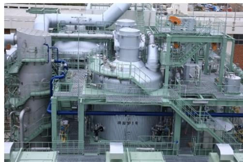
■ 過給式流動燃焼システム
