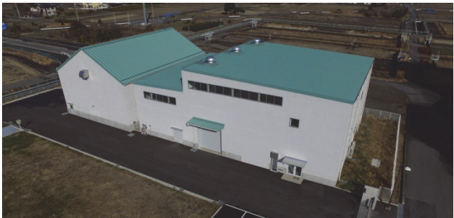
尾張西部浄水場 脱水設備
