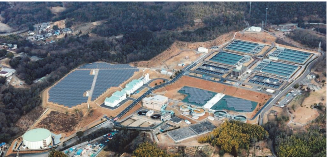
犬山浄水場 脱水・発電設備
